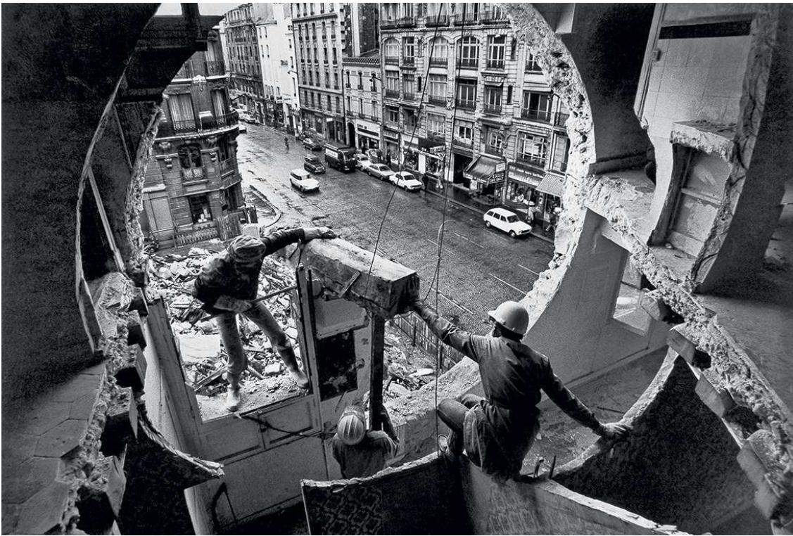
Gordon Matta-Clark et Gerry Hovagimyan travaillant à Conical Intersect Rue Beaubourg, 1975 Harry Gruyaert © Harry Gruyaert / Magnum Photos
